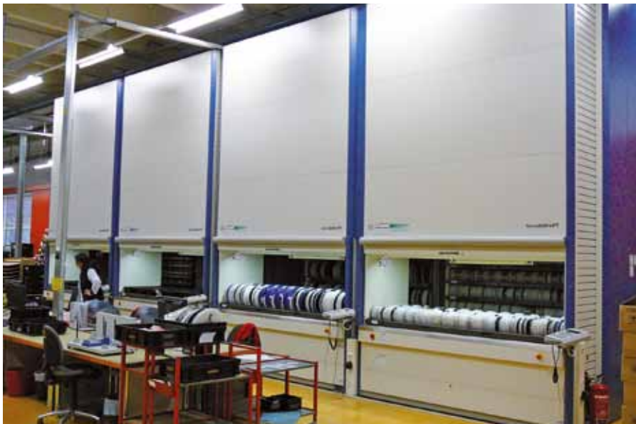
Rund 20.000 verschiedene Komponenten lagern in vier Lean-Liften
